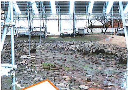
ただ今庭園内を修復工事されております。写っているのは池の部分です。
