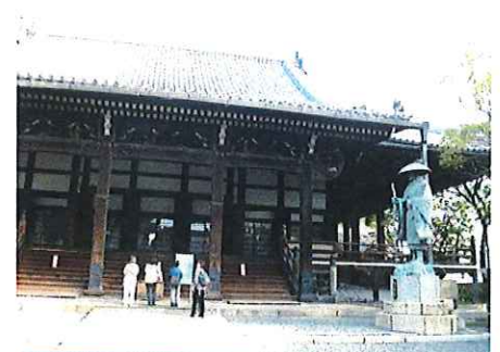
「本願寺堺別院」明治時代には県庁として使用されていた堺市最大の木造建築物です。
